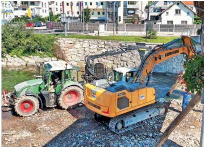
Sanacija lesenega opornika na Neškovi brvi FOTO: ARHIV OBČINE
