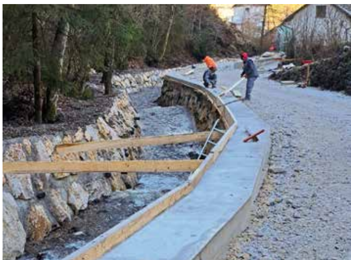
Zaščita ceste ter poglobitev in razširitev struge vodotoka v Delnicah FOTO: ARHIV OBČINE
