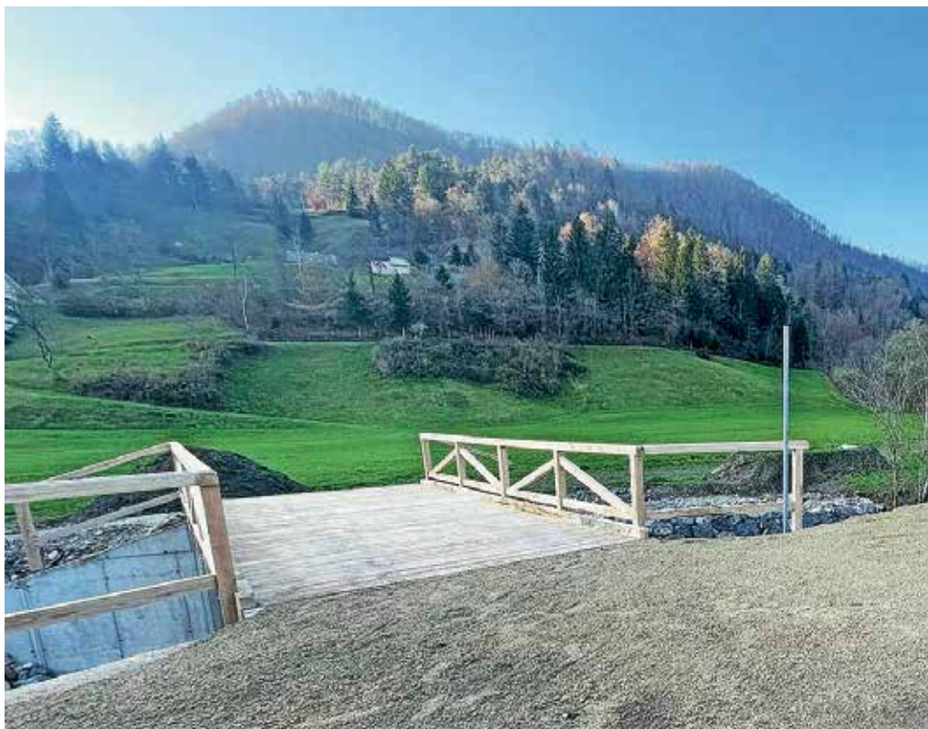
Nadomestni most na Hotavljah pri Tesnarju FOTO: ARHIV OBČINE
