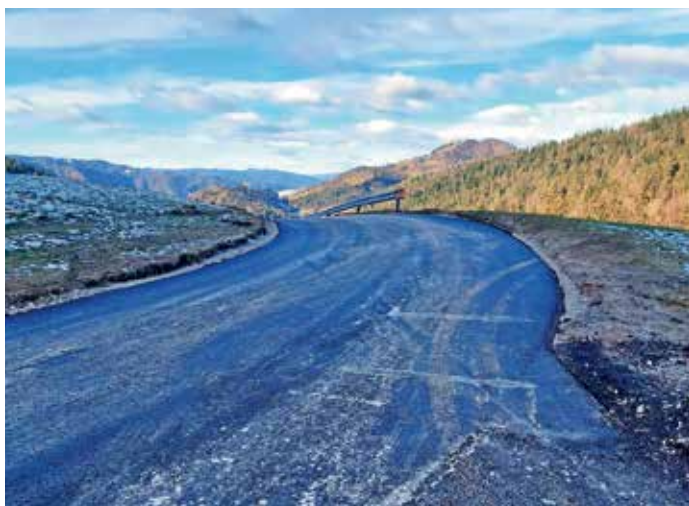
Obnova lokalne ceste Sovodenj–Javorjev Dol FOTO: ARHIV OBČINE
